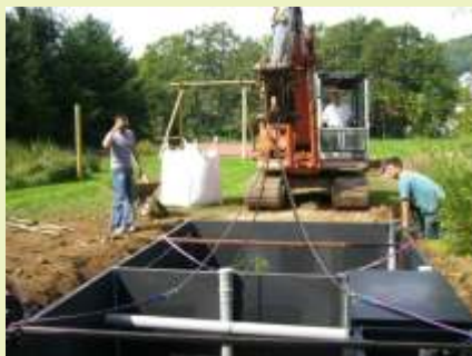
Der Transport zur Baugrube und das Einsetzen erfolgt mit dem Bagger.
