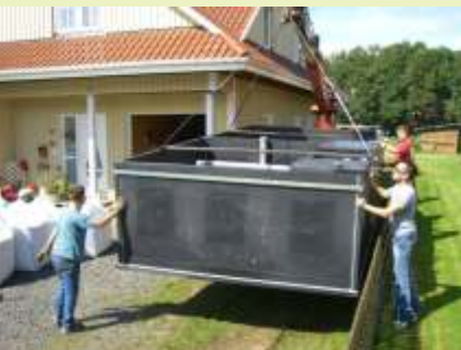
Der Transport zur Baugrube und das Einsetzen erfolgt mit dem Bagger.
